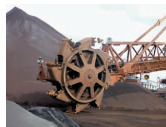
製鉄原料工場（リクレーマー）
